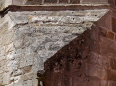
Eine Untersuchung der Turmmauern hat gezeigt, dass am Zwickel der Süd-Ost-Seite des Turms Wasser in das Gemäuer eindringt. Die Verfärbungen der Maueroberfläche und besonders ausgeprägte Verwitterungsschäden an den angrenzenden Mauerbereichen zeigen einen dringenden Handlungs-
