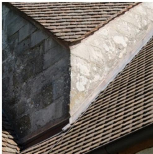
Die Kante des Kirchenschiffdaches zum Turm hin muss neu abgedichtet werden, weil bei Schlagwetter immer wieder Wasser an der Turmwand abläuft und ins Gebäudeinnere gelangt, so dass wir bereits Wasserspuren an der Turmwand im Kirchenschiff gesehen haben.
